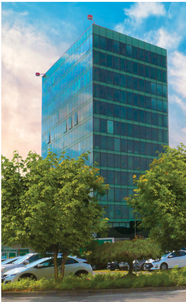
Bericah S.p.A. - Torri di Quartesolo (VI) | Sede Direzionale
